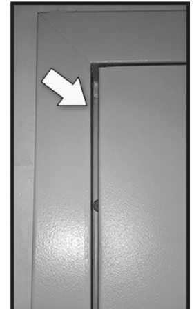
Fig. 13 Excessive Gap at Latch Edge
